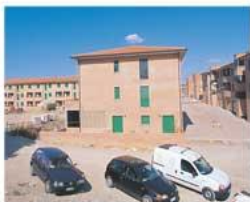
L'insediamento delle Cerchiaia. 64 alloggi sono stati costruiti dalla cooperativa Orsa Maggiore e 49 dalla cooperativa Co.n.edil
