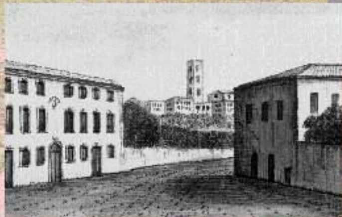
Casa di Valli: sullo sfondo il campanile dei Servi
