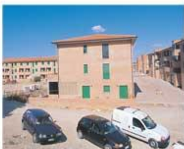
L'insediamento delle Cerchiaia. 64 alloggi sono stati costruiti dalla cooperativa Orsa Maggiore e 49 dalla cooperativa Co.n.edi
