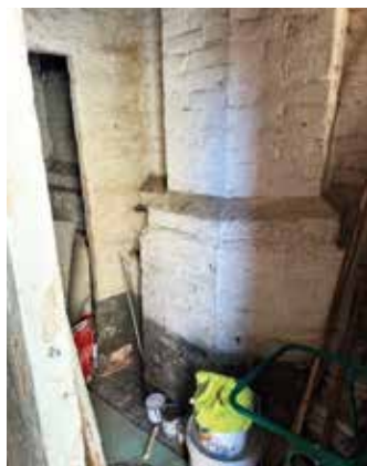
Interno del sottoscala, particolare
